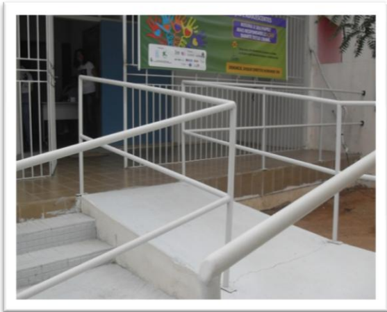
Figura 01 – Rampa de Acesso/ CREAS
